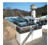
Tratamiento de agua
