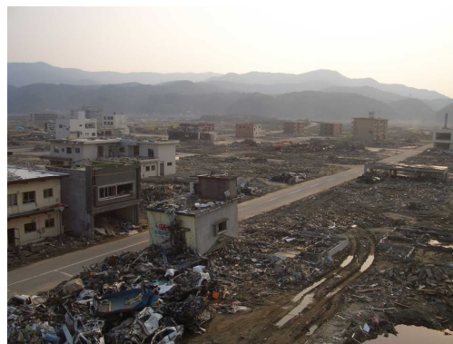
▲東日本大震災の被災状況
