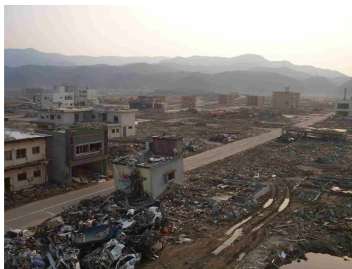
▲東日本大震災の被災状況
