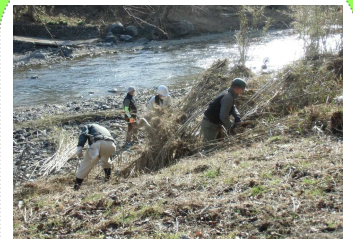
景観整備作業
