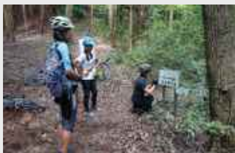
散策路案内板の補修
