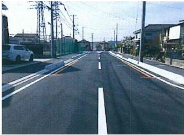
道路整備工事
