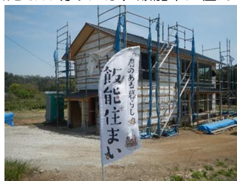
(建築現場の様子)
