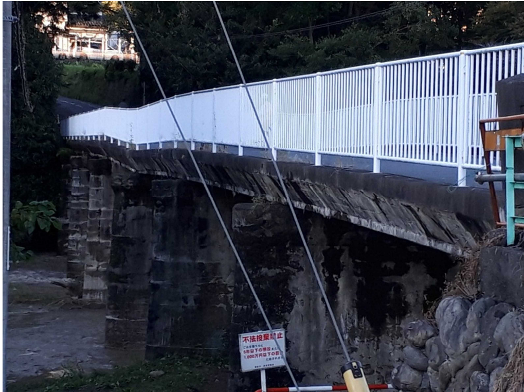
【清川橋】 飯能市道1－8号線（飯能市大字前ヶ貫地内） （左岸側から右岸側を望む）
