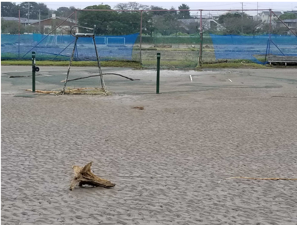
阿須テニスコート (土砂・流木の堆積、土の流出、ネットフェンス破損)
