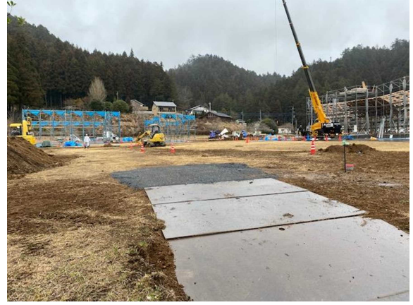
〈野外ステージ建設工事ほか〉
