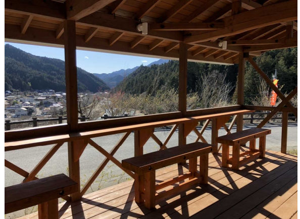
〈屋外テラスカウンター設置〉
