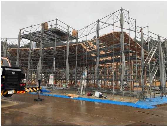
〈野外ステージ建設工事〉
