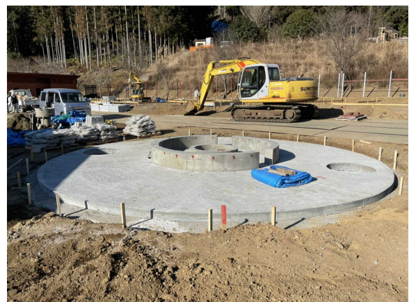
ファイヤーピット設置工事
