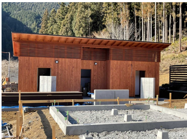
宿泊者用トイレ建設工事
