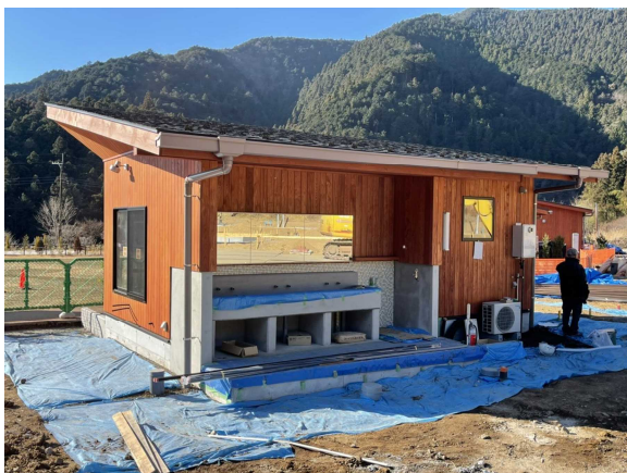
管理棟建設工事
