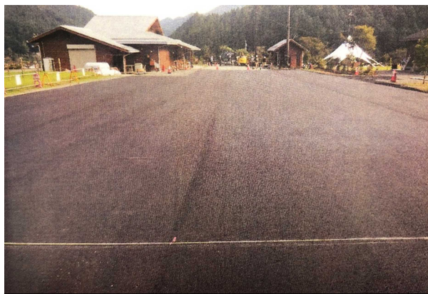
カフェ&ショップ ヤマセミ側駐車場舗装工事
