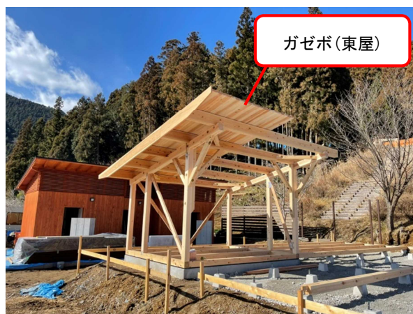
グランピングデッキ基礎工事
