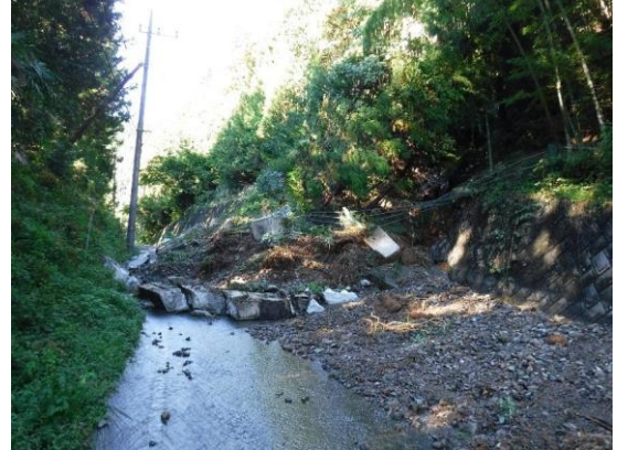
「令和元年東日本台風」による飯能市道 8-3 号線の土砂崩れ
