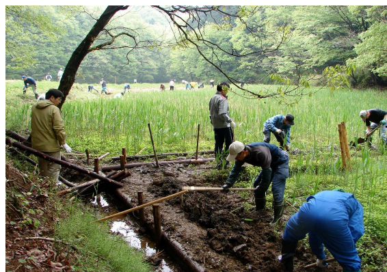
間伐材の丸太を埋めて畦道づくり
