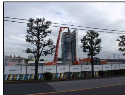
●煙突の重機解体の例
