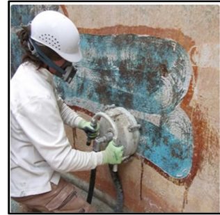
●アスベスト除去状況の例
