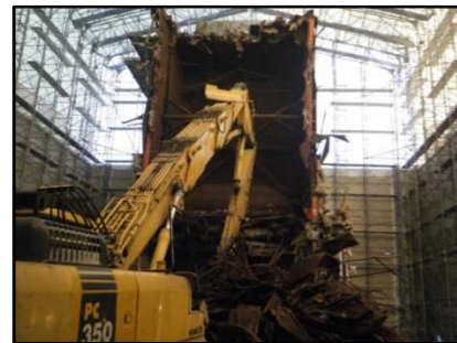
●焼却器機類の重機解体の例
