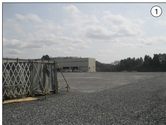
北西側より全景
