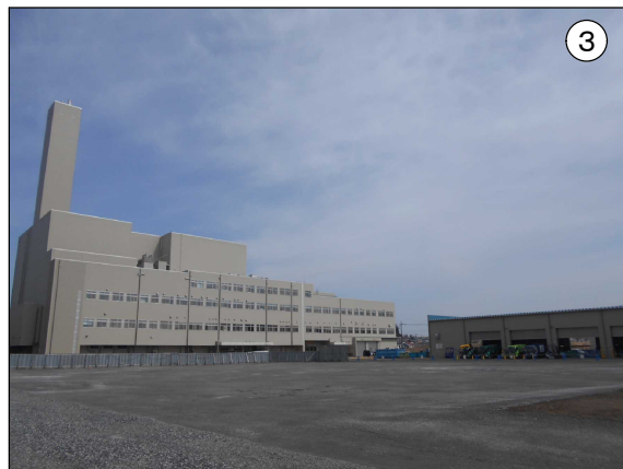
南西側より全景
