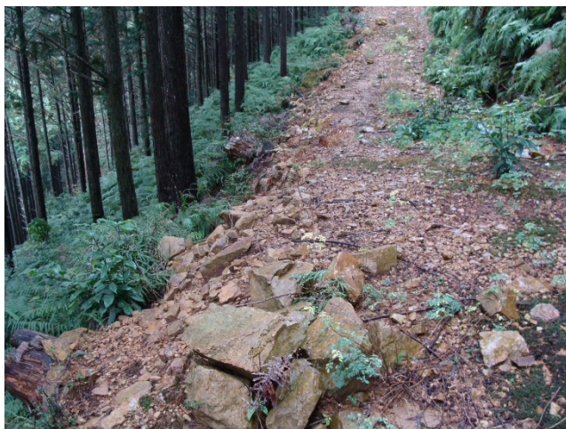
除去した崩土による路肩の強化
