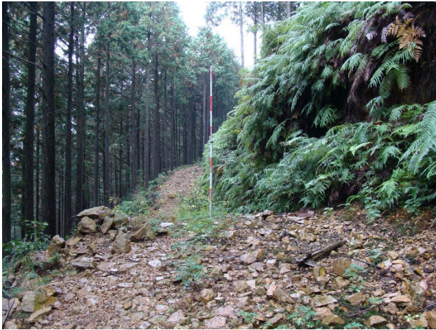
堆積岩質礫質土(砂岩)の切土のり面
