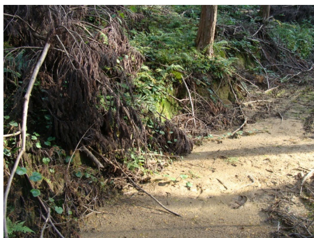
路面に堆積した軟弱な土砂
