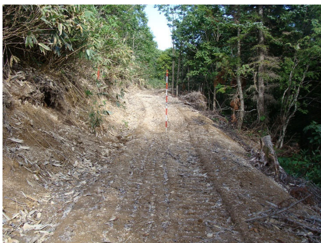
施業終了後の路面整正の必要性
