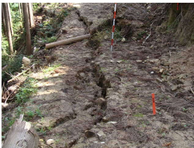
締固め不足による盛土の沈下「参照 P43②締固め」
