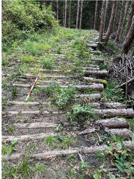
丸太により路面を保護している事例
