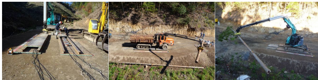
負荷試験の状況
