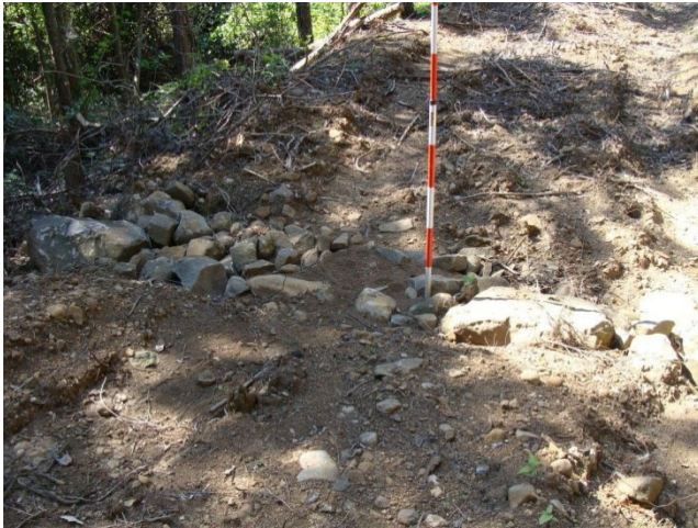
排水施設への現地発生材の利用例
