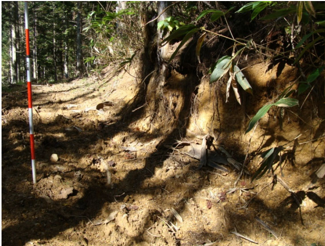
火山灰質粘性土の切土のり面
