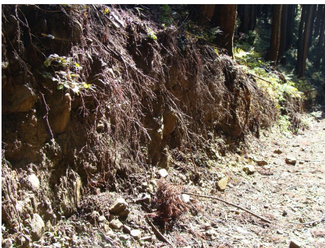
堆積岩質礫質土（砂岩）の切土のり面
