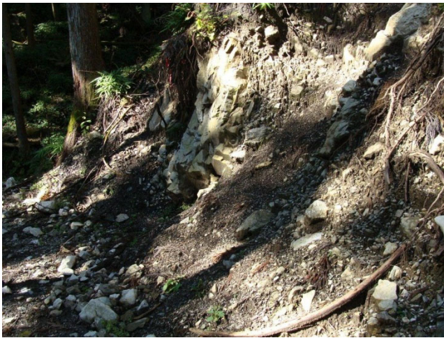
堆積岩質礫質土（秩父帯）の切土のり面
