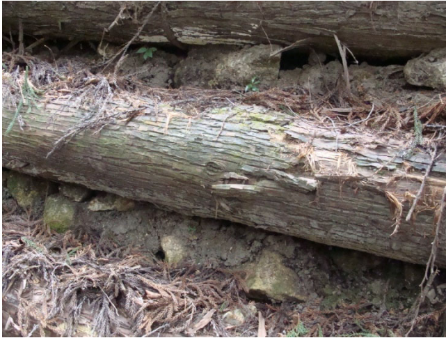
丸太組工前面に石礫を利用した一例
