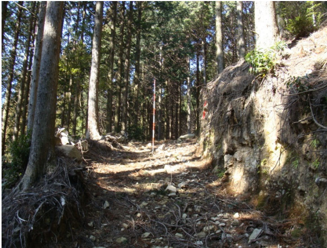
四万十累層の堆積岩質礫質土の切土のり面
