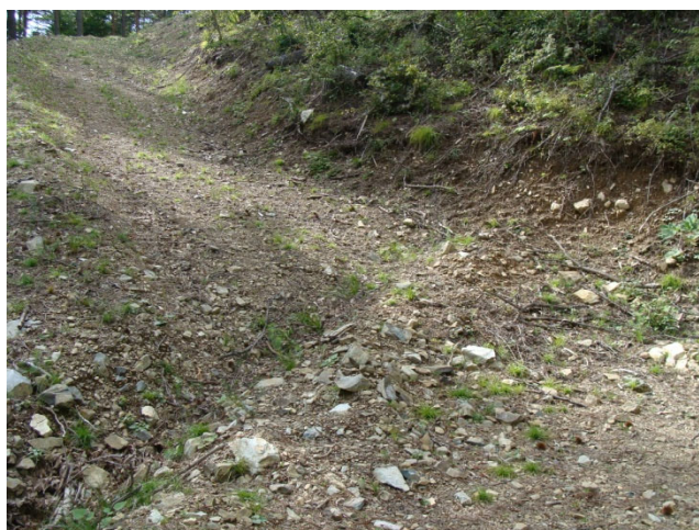
素掘りによる横断溝
