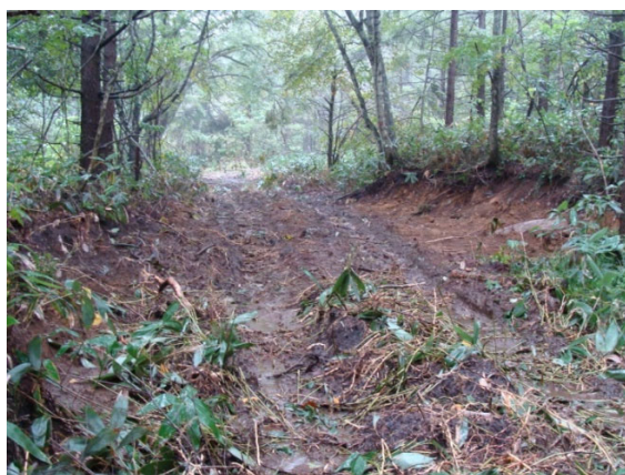
黒ボクが発達している箇所の路面の状況
