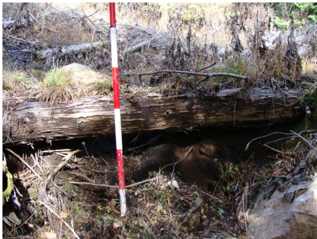
背面から土砂が流亡した一例
