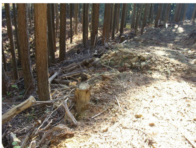
集水箇所手前に設置された横断溝
