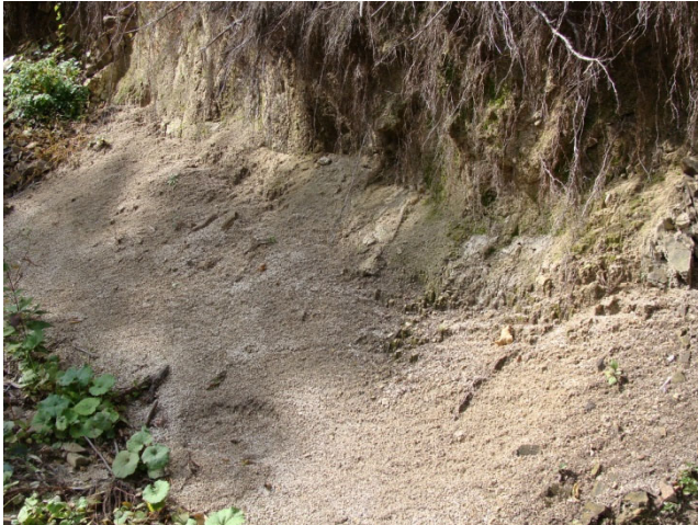
風化したまさ土ののり尻の堆積物
