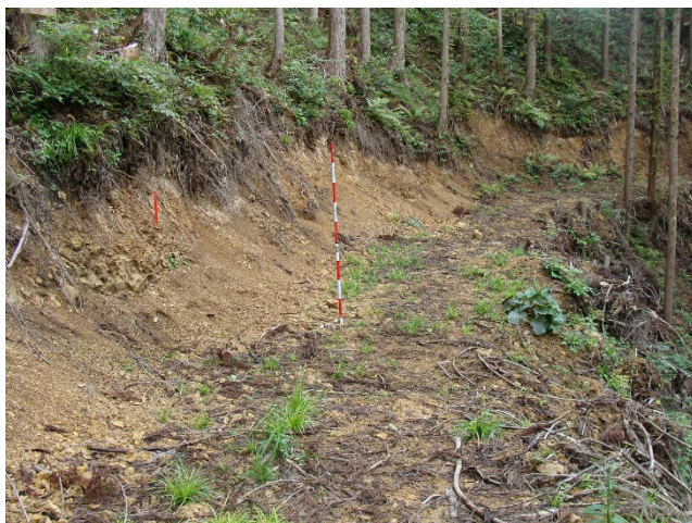
幅員確保のための崩土の除去
