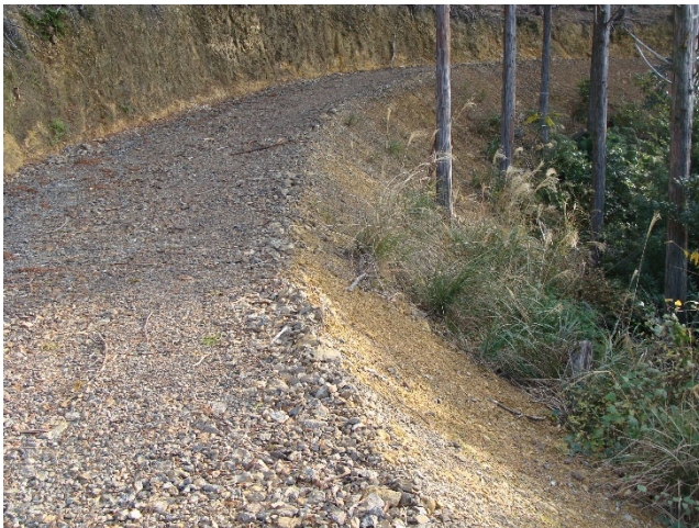
路面への現地発生材の利用例
