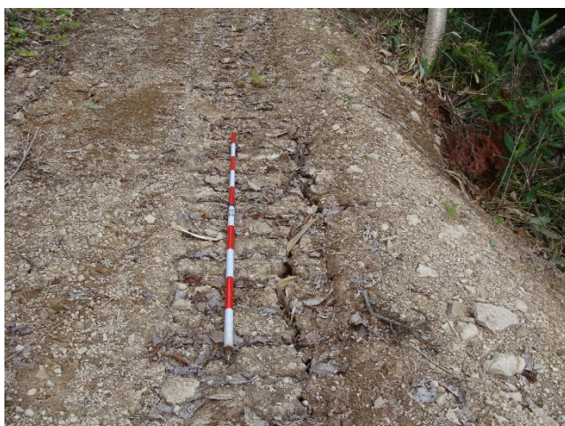
修復による盛土強度低下の抑止
