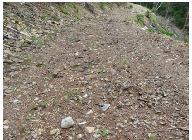
比較的締固められた盛土断面
