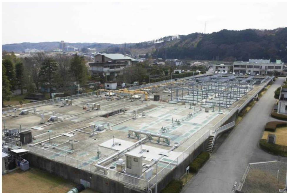
飯能市浄化センター
