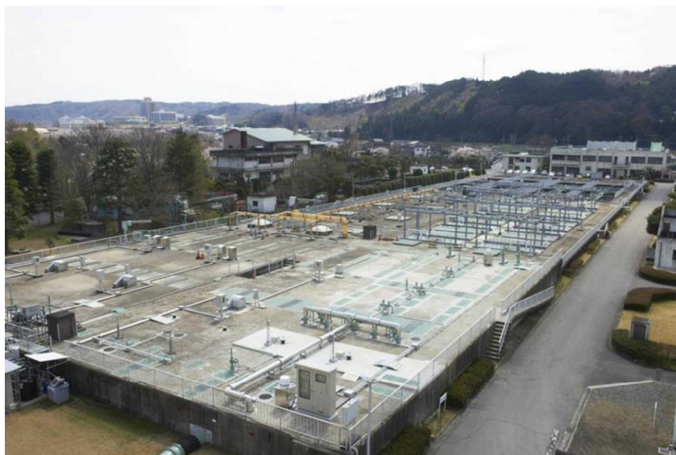
飯能市浄化センター
