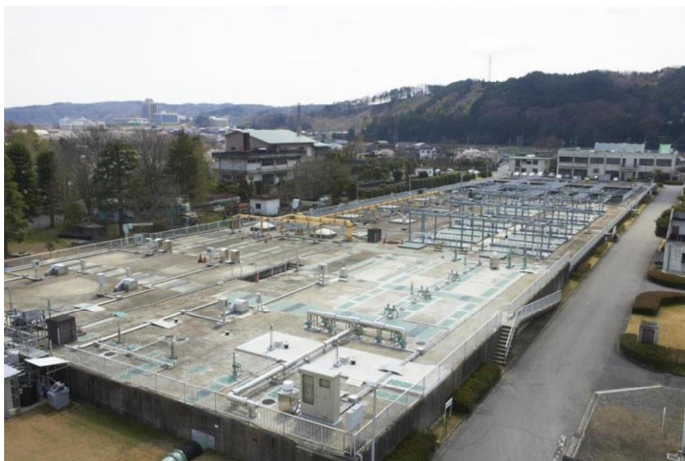
飯能市浄化センター
