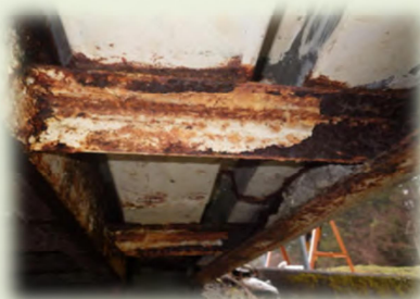
腐食 塗装が腐食している状態
