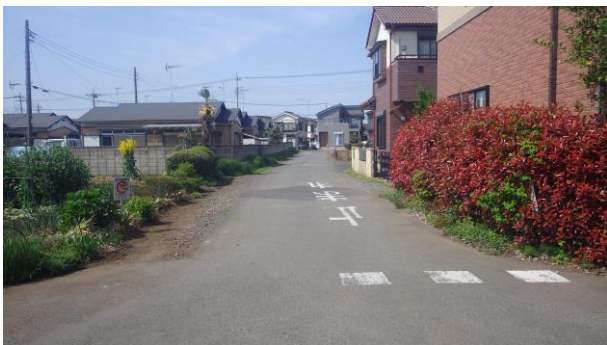
① 区6-2号線ほか道路整備工事
