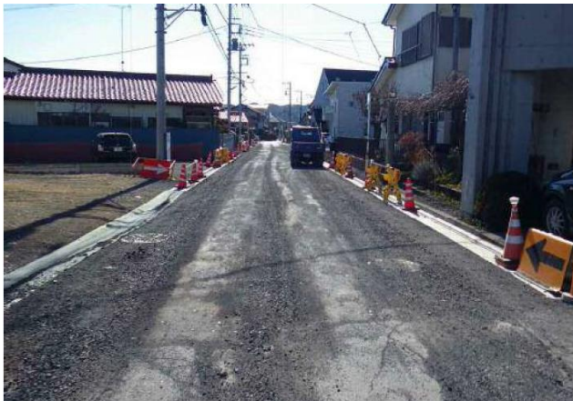
区6-33号線施工箇所
