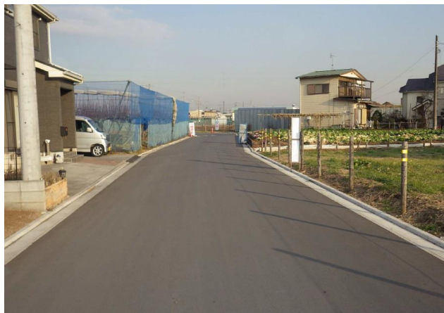
区6-20号線施工箇所
