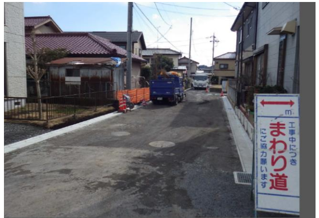
区6-16号線施工箇所
