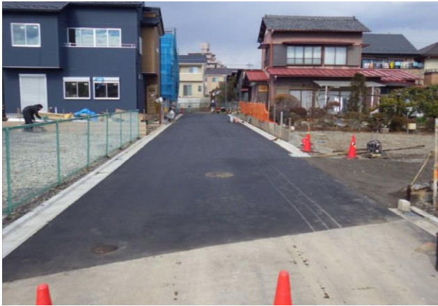
区6-2号線施工箇所
