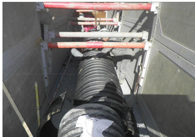
区9-2号線施工箇所
