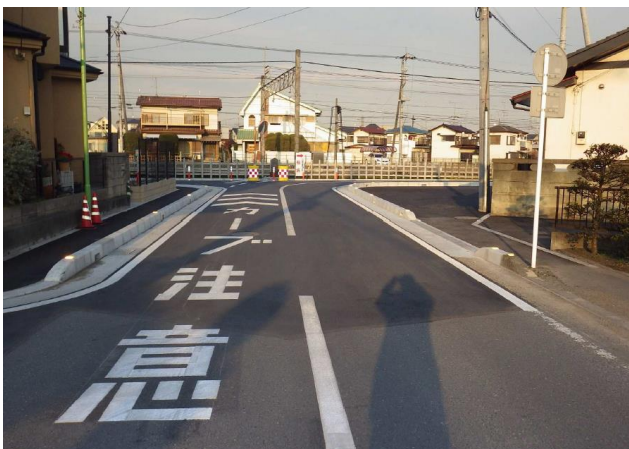
区9-7号線施工箇所
