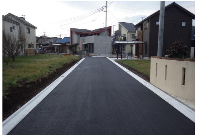
区6-79号線施工箇所
