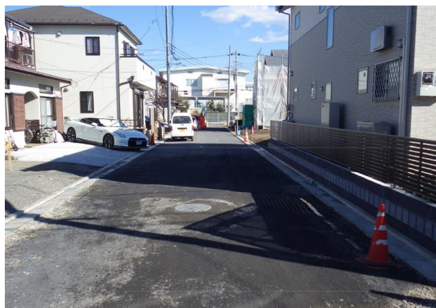
25街区施工箇所
