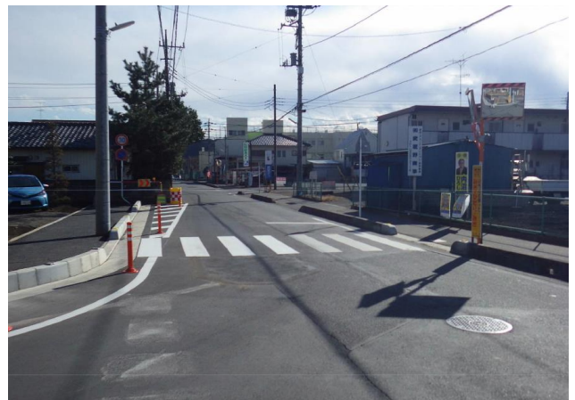
区10-2号線施工箇所
