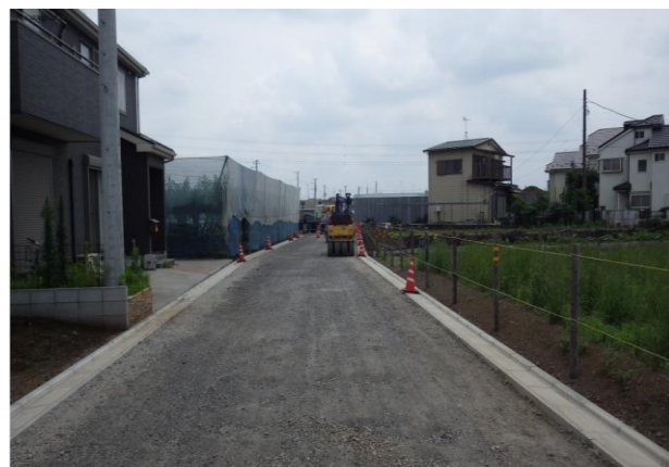
区6-20号線施工予定箇所
