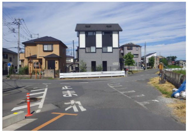
区9-7号線施工予定箇所
