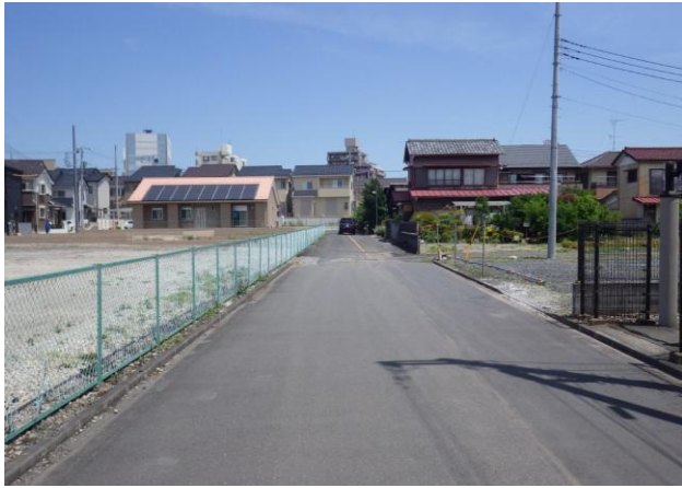
区6-2号線施工予定箇所
