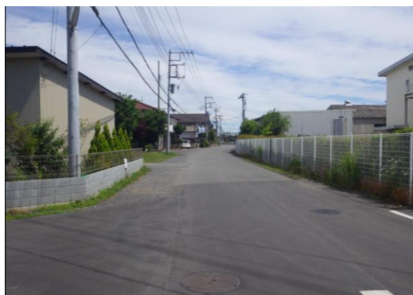
区8-1号線施工予定箇所
