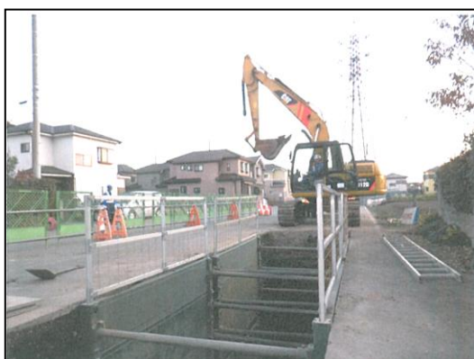
【 工事箇所 NO.1 】
