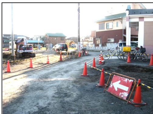
【 工事箇所 NO.1 】
