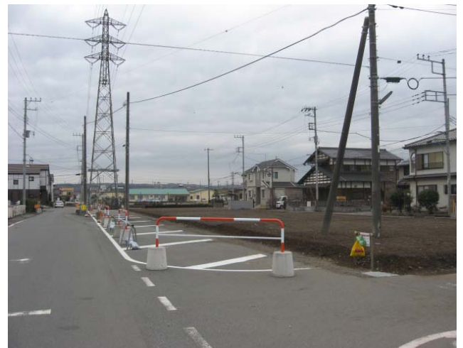
18街区の造成状況
