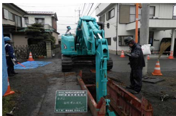
下水道管の布設工事の様子
