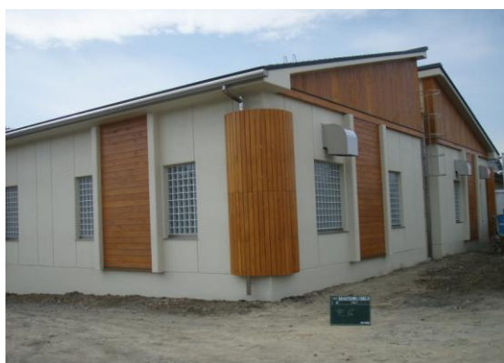
岩沢汚水中継ポンプ場
