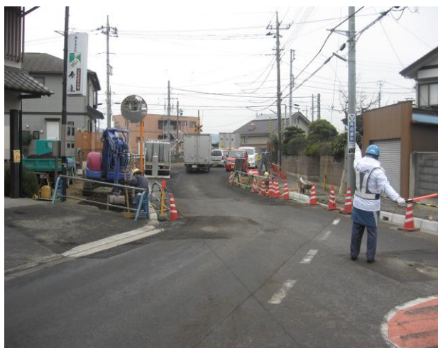
J R八高線六道踏切北側の状況
