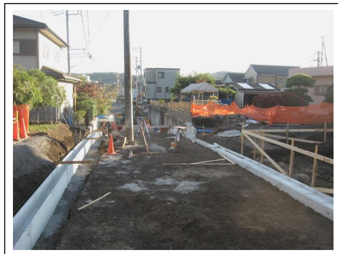
【 工事箇所 NO.4 】
