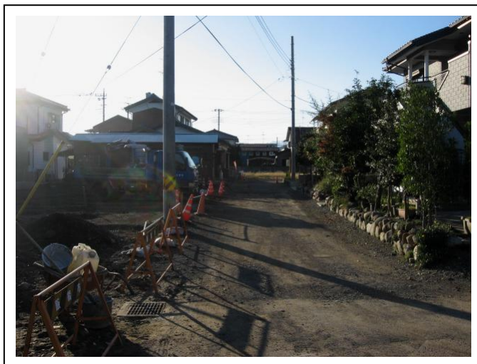
【 工事箇所 NO.3 】
