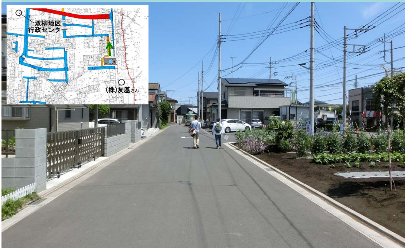
整備済みの区画道路（幅員 6 m）
