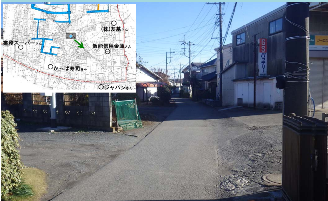
未整備の道路（幅員 4 m）
