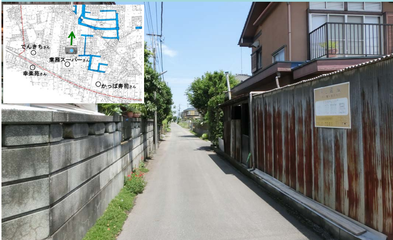
未整備の道路（幅員 4 m未満）
