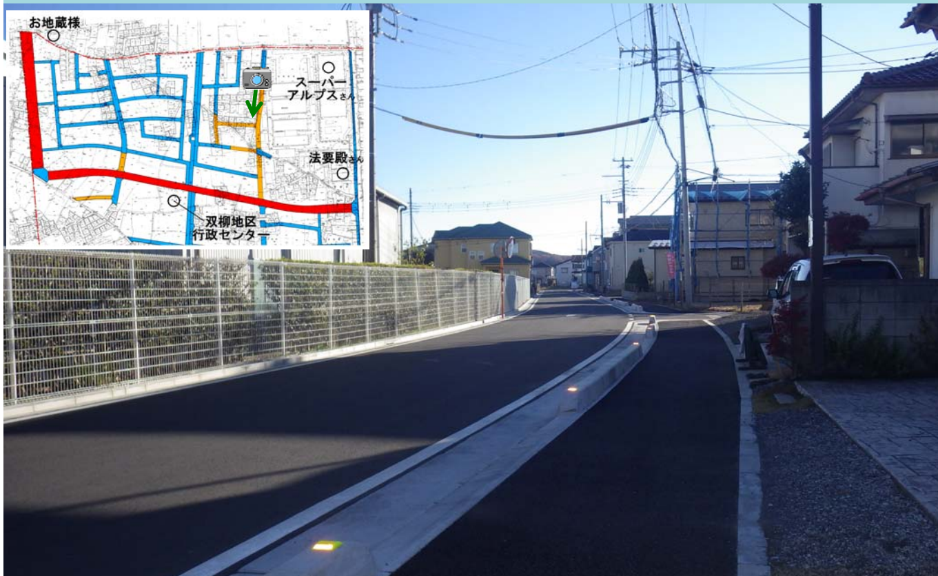
整備済みの区画道路（幅員 8 m）
