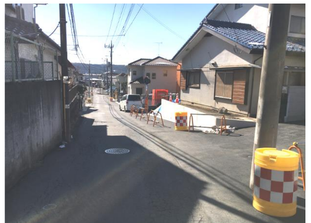
⑥ 市道 1-1829 号線実施状況
