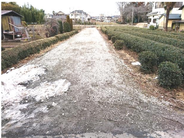
⑨ 阿須小久保線工事用道路実施状況
