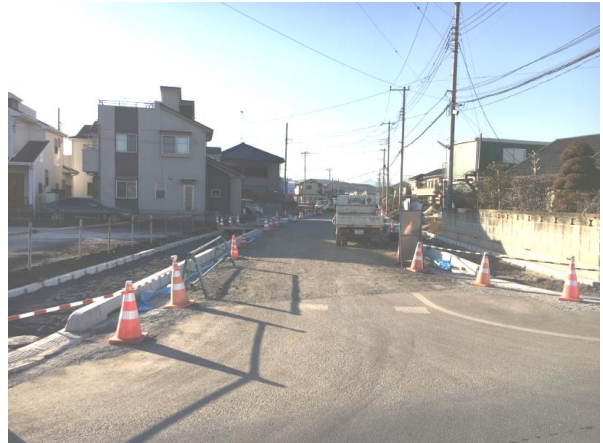
② (都) 川寺岩沢線実施状況
