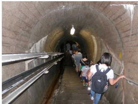
有間ダムの中（監査廊）
