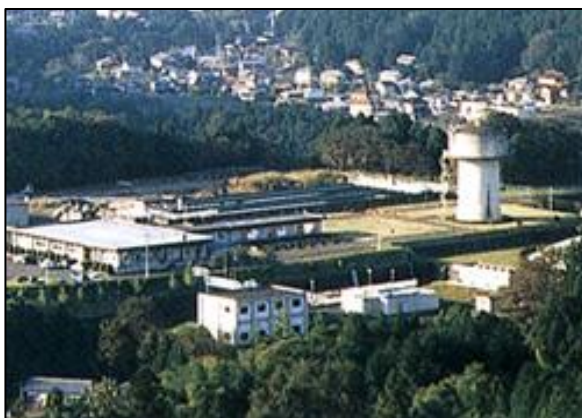
小岩井浄水場（第3期拡張事業）
