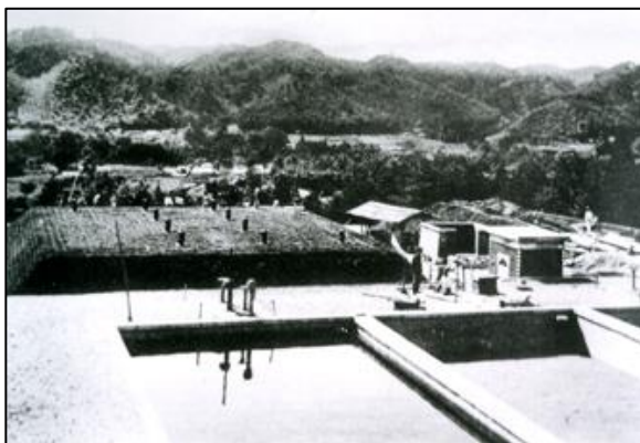
白山浄水場 (創設事業)
