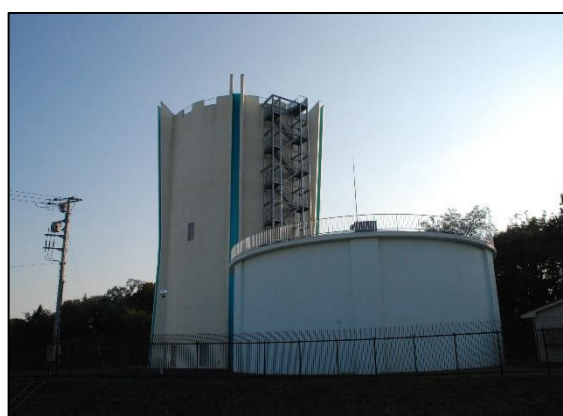
大河原配水場（第4期拡張事業）
