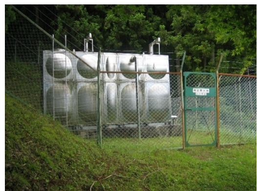
名栗高区配水池
