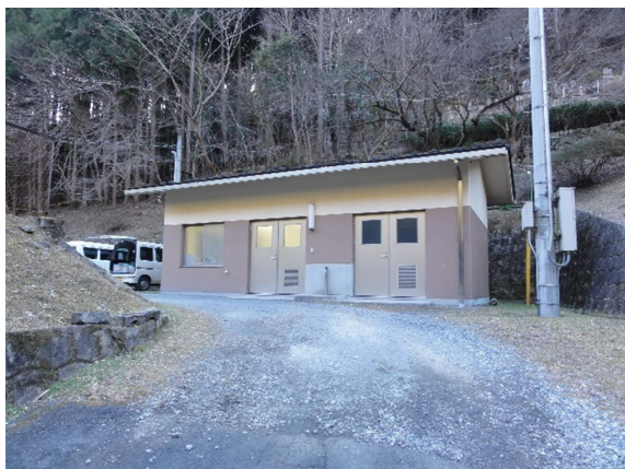
両吾野浄水場 管理棟
