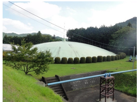
小岩井浄水場 第一配水池
