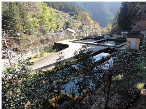
上吾野浄水場 外観
