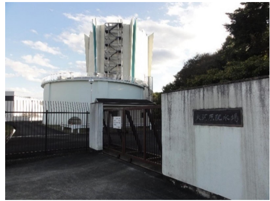
大河原配水場
