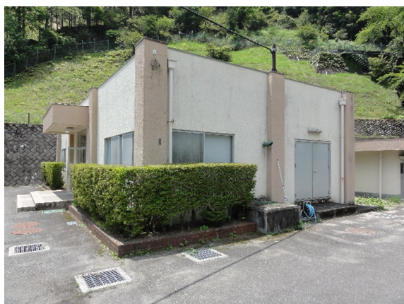
名栗浄水場 管理棟
