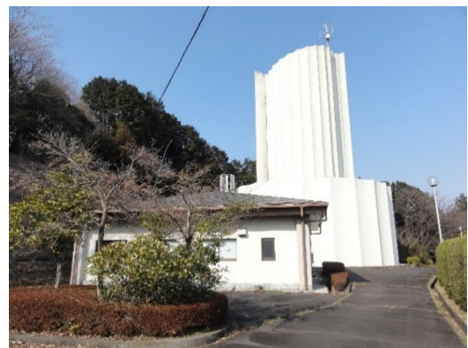
美杉台配水場
