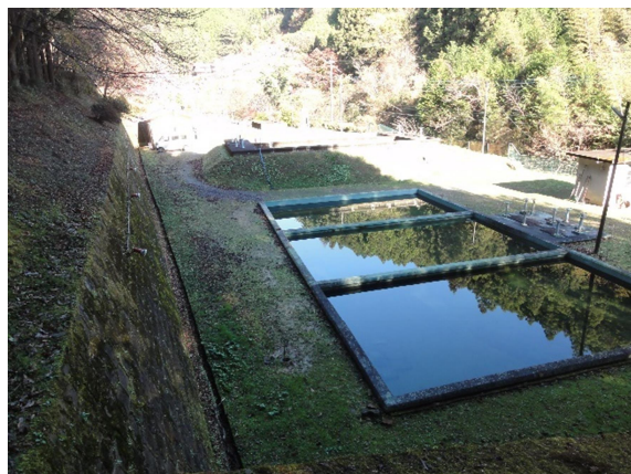
沈澱池、緩速ろ過池
