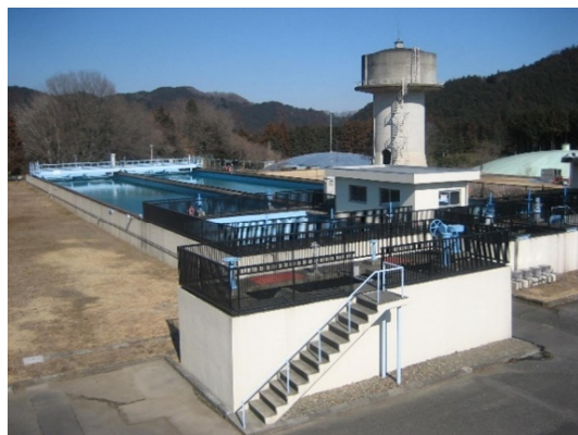
着水井、沈澱池
