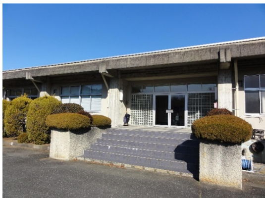
小岩井浄水場 管理棟
