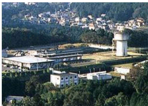
小岩井浄水場（第3期拡張事業）
