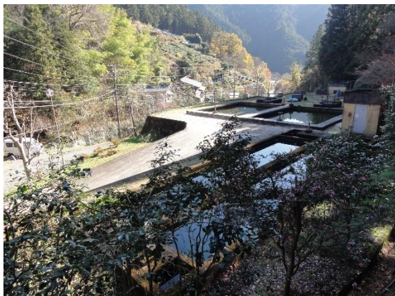
上吾野浄水場 外観
