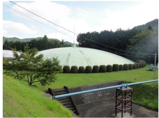
小岩井浄水場 第一配水池
