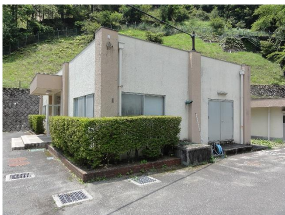
名栗浄水場 管理棟
