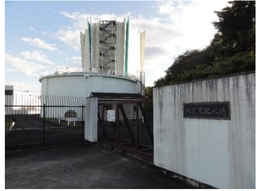
大河原配水場
