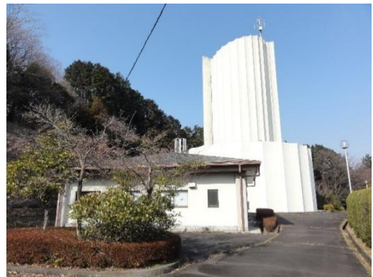
美杉台配水場
