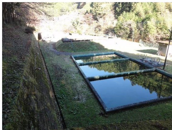
沈澱池、緩速ろ過池
