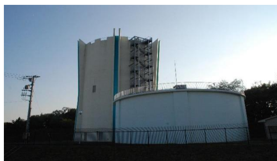
大河原配水場（第4期拡張事業）
