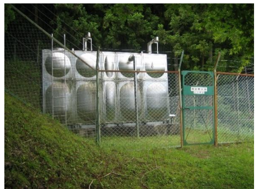
名栗高区配水池
