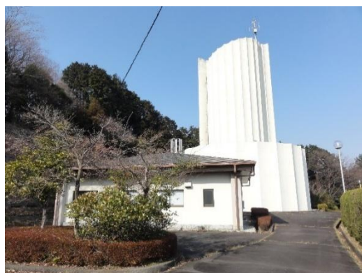
美杉台配水場
