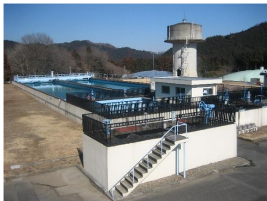
着水井、沈澱池
