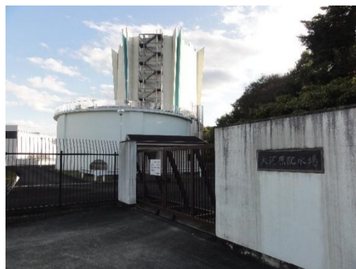
大河原配水場
