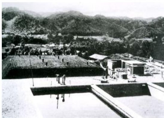
白山浄水場（創設事業）
