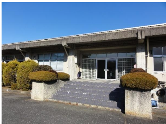
小岩井浄水場 管理棟
