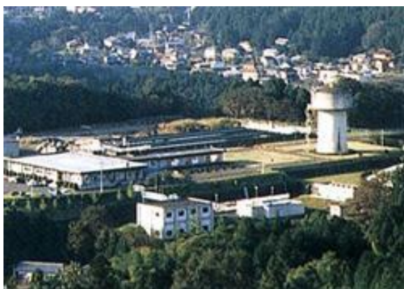
小岩井浄水場（第3期拡張事業）
