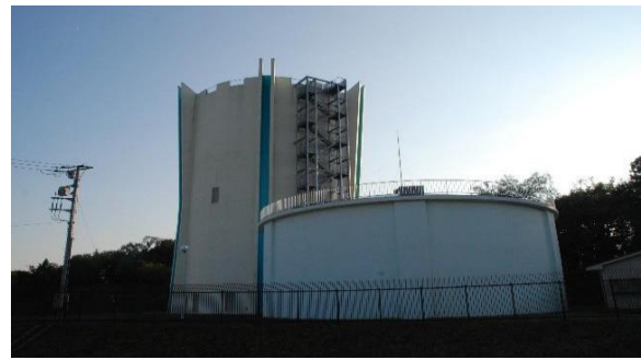
大河原配水場（第4期拡張事業）
