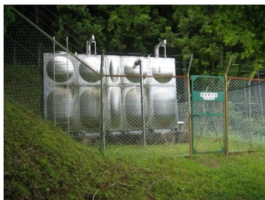
名栗高区配水池
