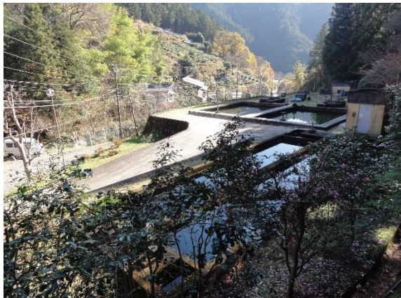
上吾野浄水場 外観
