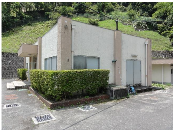
名栗浄水場 管理棟
