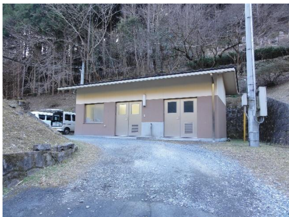
両吾野浄水場 管理棟
