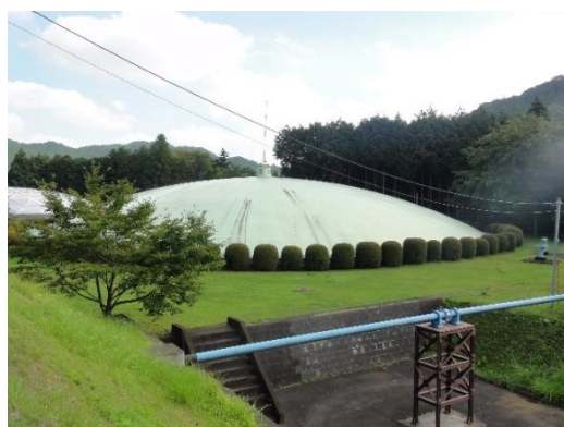
小岩井浄水場 第一配水池
