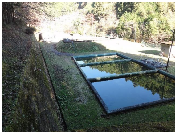
沈澱池、緩速ろ過池
