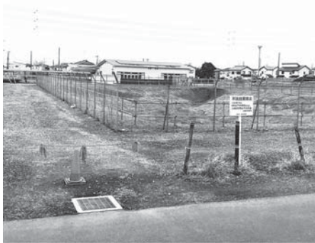
双柳公民館西の調整池
