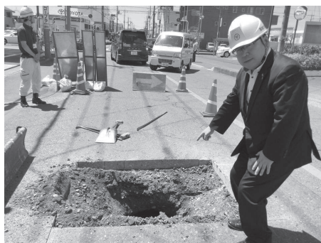
路面下空洞調査（本人撮影）
