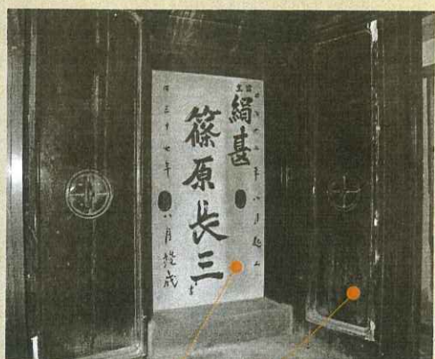
引き戸 観音扉 一階奥観音扉
