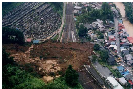
写1-17 吾野駅裏山の土砂崩れ
