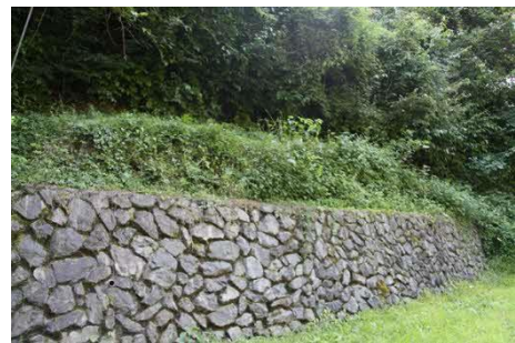
写2-32 石灰焼場跡
