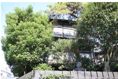
写2-27 木造3階建て料亭建築
