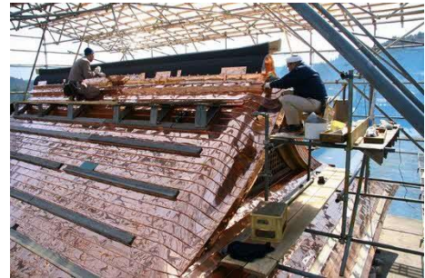
写5-3 長光寺三門修理風景
