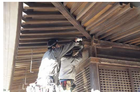
写5-5 防災設備設置工事 (福德寺)
