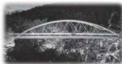
12基のスポットライトによりアーチ部分を夜間空間に浮かび上がらせ、欄干部には総延長170mのLEDライン照明を配して歩道部分を照らしながら、大型カラーLED照明により橋全体を多彩な色彩で照射します。また、橋周辺の樹木などにもライトアップを施し、橋と河原の一体的な夜間景観を演出します。
