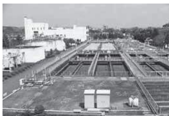
飯能市浄化センター
