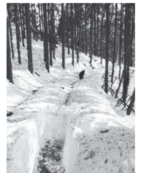
【平成26年2月の降雪の様子】 市内長沢地区での除雪作業
