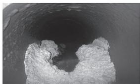
左の写真は、下水道管に油が流れて滞留し、管が閉塞してしまっている様子です。油など下水道に流してはいけないものを流してしまうと、下水道管が詰まったり損傷する恐れがあります。また、浄化センターでも汚水の処理に負担がかかります。
