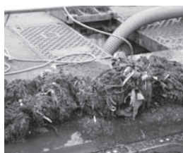
下水道施設の清掃で撤去されたゴミ
