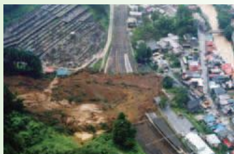
吾野駅南側斜面崩壊状況(東上空から)
