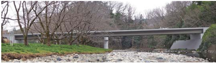
←左岸側(征矢町・前ヶ貫側)
