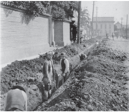
昭和6（1931）年ころの上水道配水管布設工事の様子
