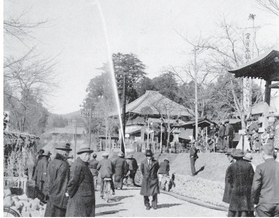
昭和7（1932）年 上水道施設完成後の様子（上水道消火栓）
