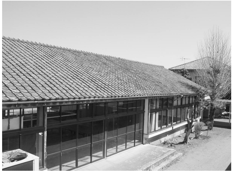
旧平岡レース食堂棟外観
