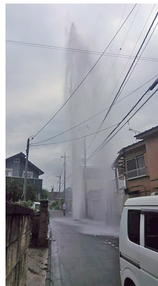
破裂による漏水の様子
